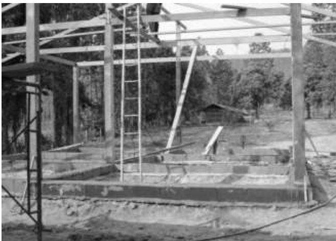
建設中の食堂 3月
