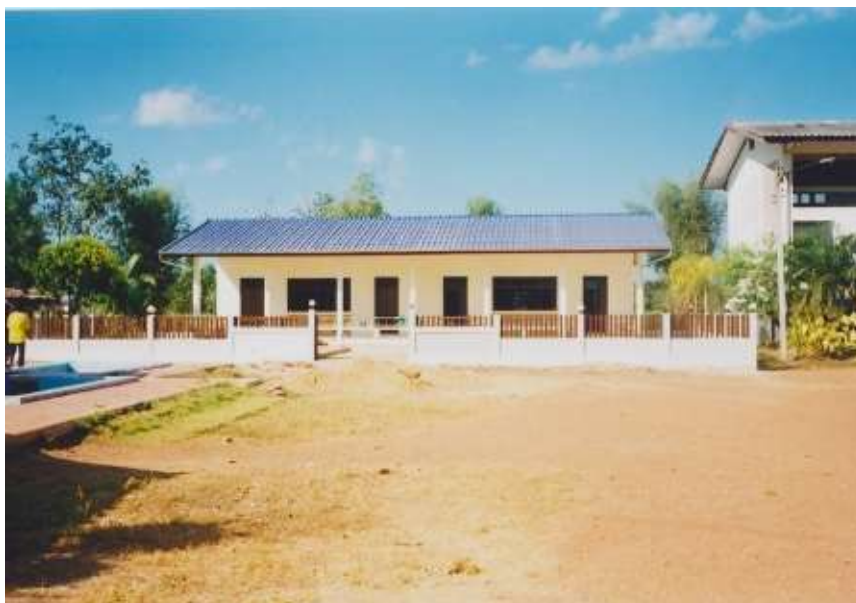
白いペンキで塗られ、フェンスも完成しました。
