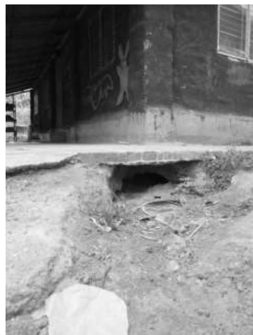
洪水により床下の土が流され大きな穴が開いた
